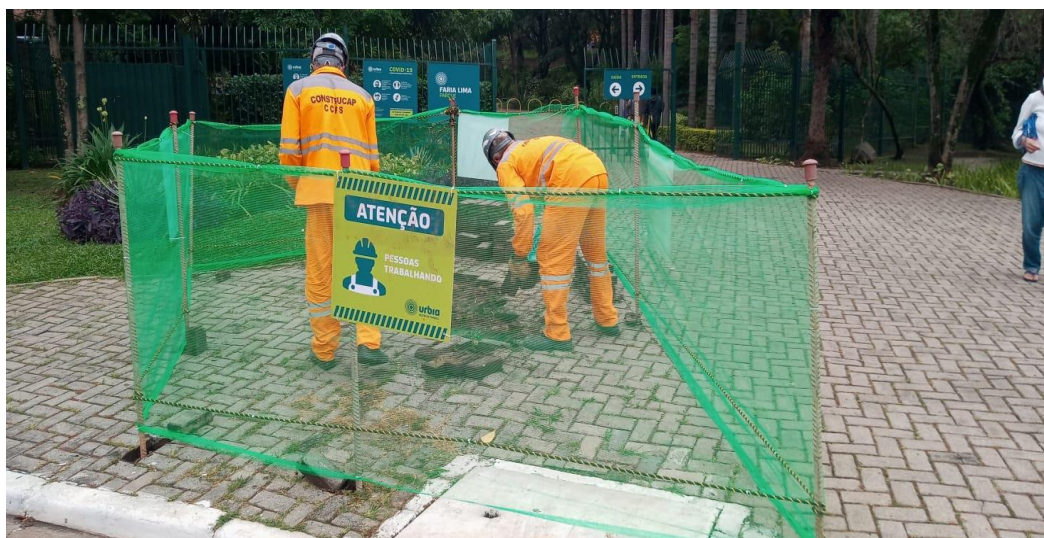
Figura 33: Manutenção realizada calçada do parque
